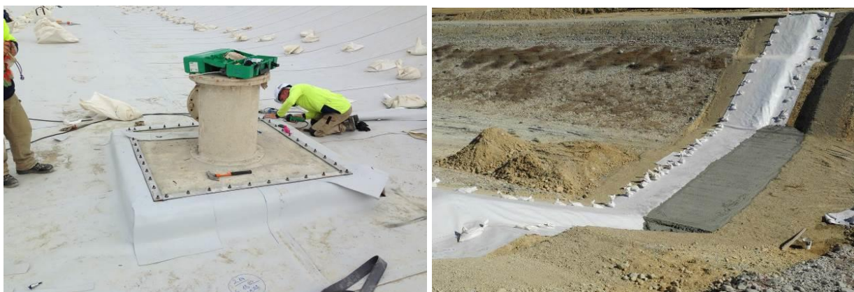
Figure 4. À gauche, ancrage transversal en tranchée. À droite, détail d'ancrage sur structure en béton. Ce type d'ancrage est à même de résister à l'eau en pression.
