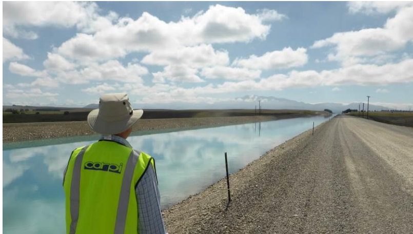
Figure 7. Le canal de Tekapo de nouveau en opération.
