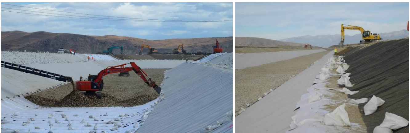
Figure 5. Mise en place de la couche de lestage au-dessus du géotextile de protection sur le fond, et sur la partie supérieure des talus : au premier plan la géogrille placée sur du gravier fin et le géotextile de protection, à l'arrière-plan les graviers sont mis en place au-dessus de la géogrille.
